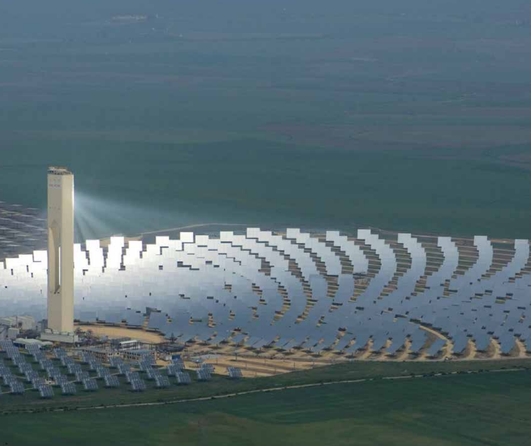
Central termosolar en la Reserva de Biosfera de Doñana. Imagen: Abengoa Solar.
