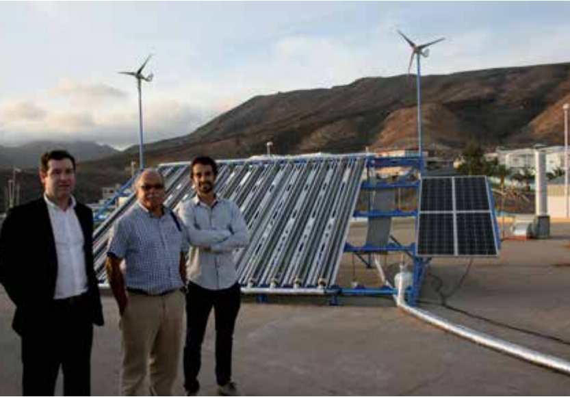
Proyecto Frío Solar en Morro Jable. Imagen: RB de Fuerteventura.
